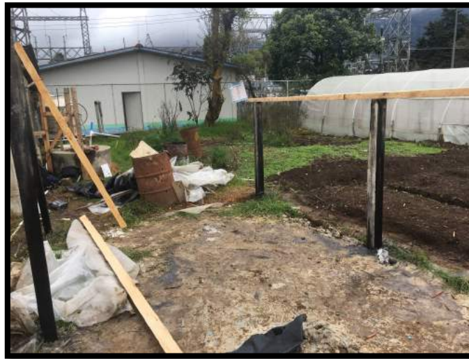
Figura 3. Construcción de invernadero tipo colombiano para establecer pilonera dentro de las instalaciones del Centro de Formación San José, Champollap, San Pedro Sacatepéquez, San Marcos.
